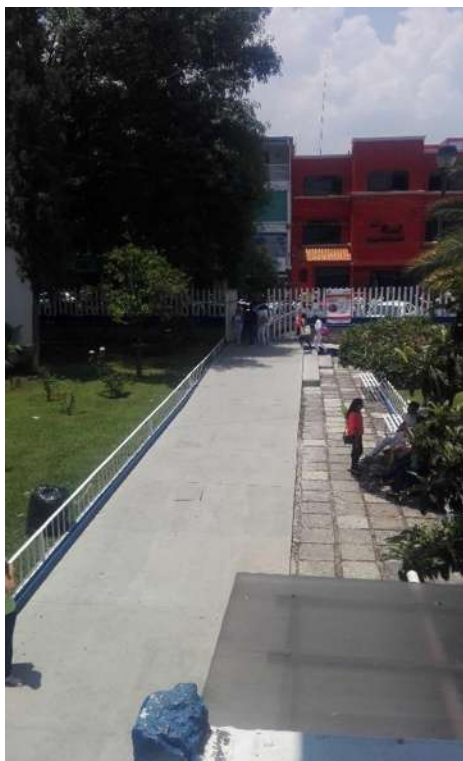
Fotografía 6.- Estado actual de pasillos de la facultad de Odontología de la UMSNH ,Creditos: Paloma Cisneros Cortes , Fecha; 19/septiembre/2017
