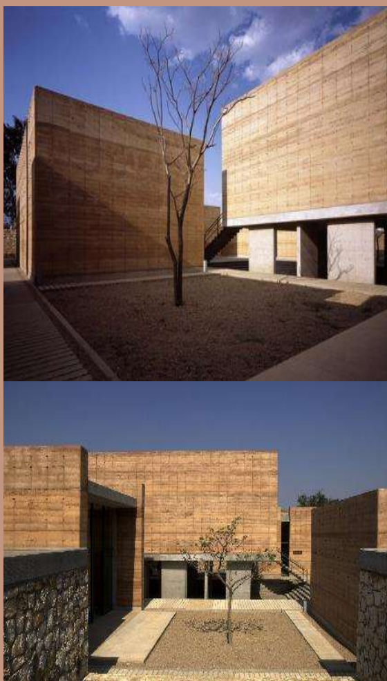
FIGURA 74: [FUENTE: ARCHDAILY], "ESCUELA DE ARTES VISUALES DE OAXACA / TALLER DE ARQUITECTURA", en: https://www.archdaily.mx/mx/750038/escuela-de-artes-visuales-de-oaxaca-taller-de-arquitectura-mauricio-
