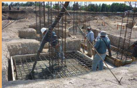
FIGURA 47: “Zapata aislada”, [Fuente: Estudio Sassani], en: https://estudioeassani.wordpress.com/2016/08/08/construccion-de-zapatas-aisladas/
