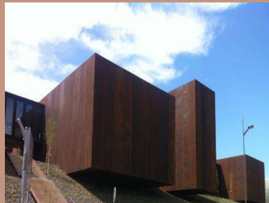
FIGURA 57: “Lámina de acero oxidado en fachadas”, [Fuente: Llätzer Moix], en: http://llatzermoix.com/es/inicio-de-la-carrera-
