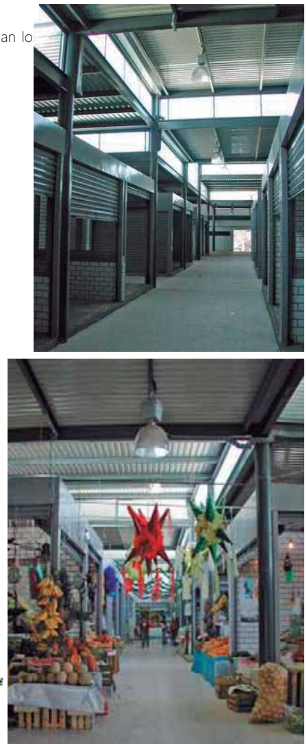
Ilustración 48 Estructura con perfiles metálicos, cubiertas de lámina de acero y diferencias de altura. Fuente: http://www.redfundamentos.com/blog/login/obras/detalle-119/
