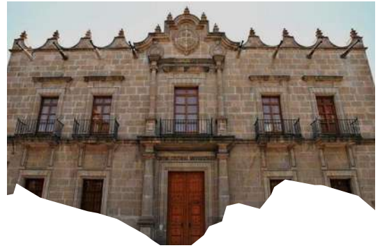
Cuamba. E. (2017). “Fachada del Centro Cultural Universitario” [Fotografía] Recuperado de: http://www.cambiodemichoacan.com.mx/nota-n21179
