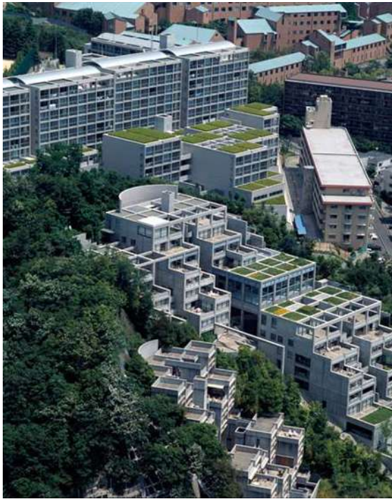
Fig. 54. Conjunto de viviendas Rokko. Fuente: Obtenido de Pinterest: https://www.pinterest.com.mx/pin/138767232241026332/ . Fecha de consulta: 12 de septiembre del 2017.
