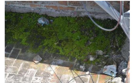
En la figura\_\_\_ al tener goteras en el techo, los locatarios cubrieron dichas goteras con losetas cerámicas añadiendo mas carga al techo y también se aprecia un cilindro de gas el cual es un riesgo ya que esta colocado sin las medidas de seguridad adecuadas.
