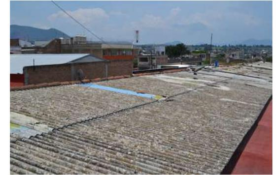
En la figura\_\_\_ se ve como sobre la azotea del mercado hay escombros generando carga muerta adicional sobre la azotea la cual por su delicado estado, tiene riesgo de colapsar.
