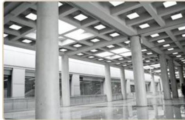
**Ilustración 49; losa reticular; tomada de: <http://cartontubos.com/linea-construccion/>**
