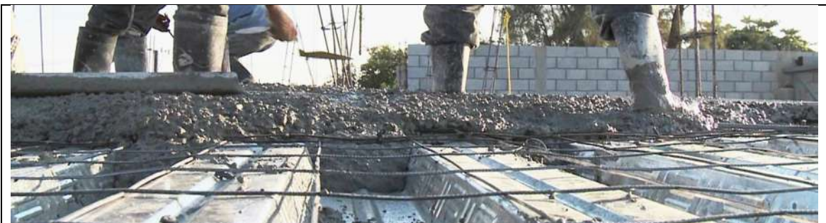
Fig. 6.3 Losacero. Fuente: http://www.pyma.com.mx/losacero-monterrey.html [08/07/2018]
