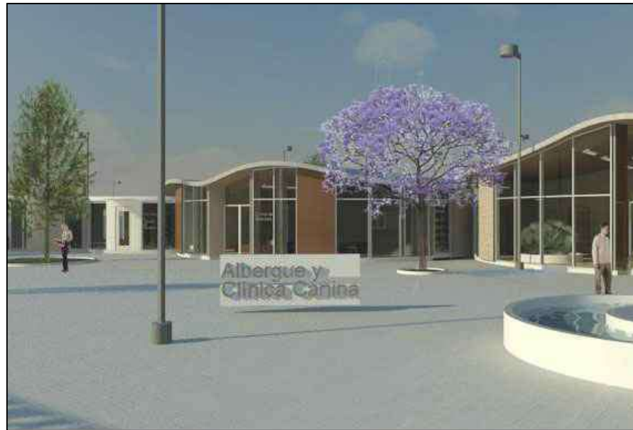
Vista este fachada principal
