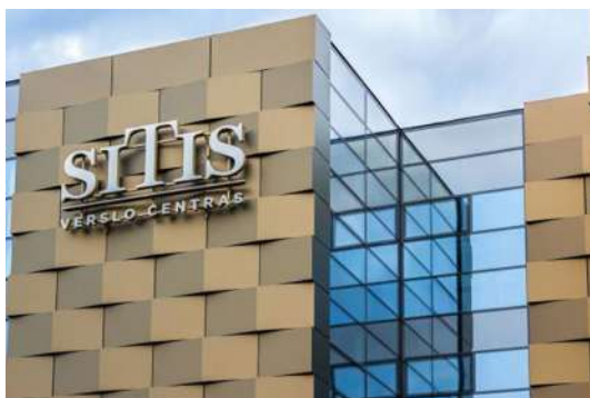
Fig. 48. Doble fachada con Alucobond, detalle de instalación. Fachada comercial tejida. Fuente: Alucobond foto: Evaldas Lasys. www.alucobondusa.com
