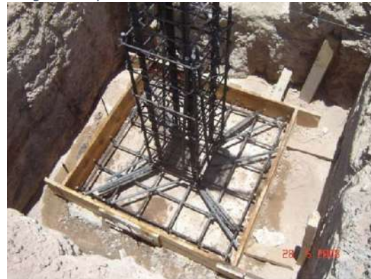
Imagen de zapata aislada
