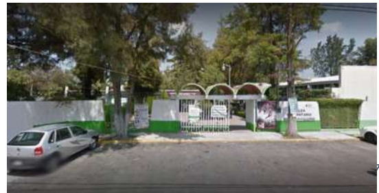
Fachada Principal del Módulo Deportivo Ojo de Agua https://www.google.com.mx/maps revisado el 26/octubre/2017
