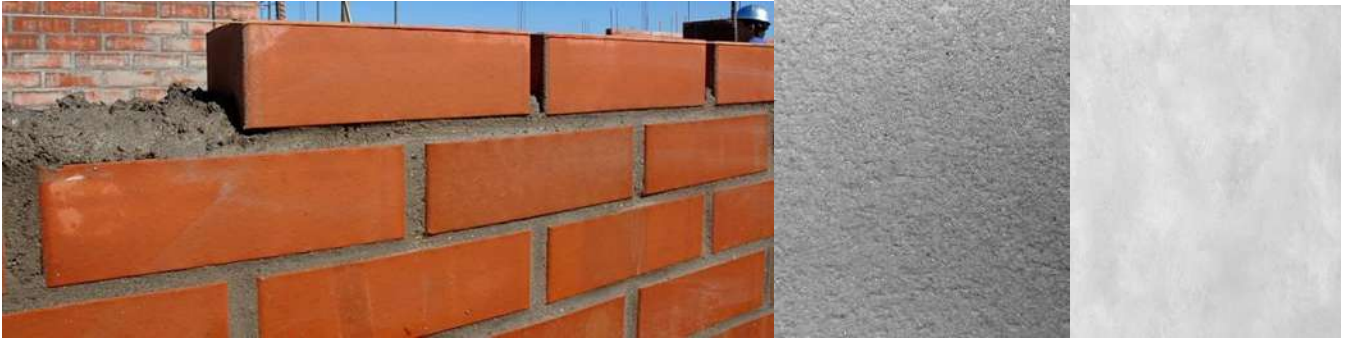
Imagen 50. Muro de tabique cerámico.
