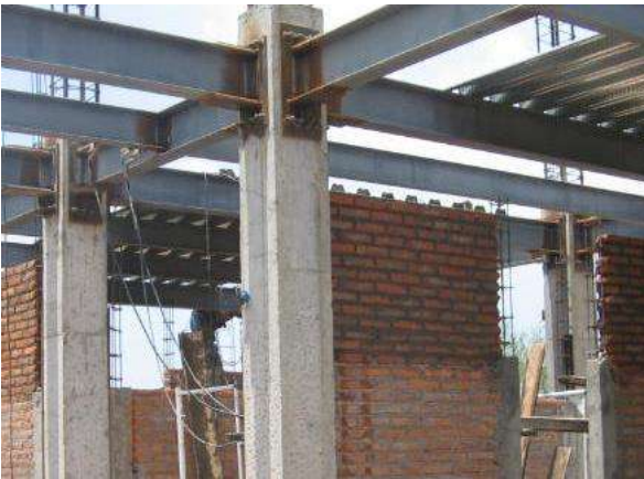
Imagen 48. Unión de vigas a columna de concreto.
