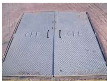
Imagen 21. Registro de la CFE. Foto: Tomada por RMN.
