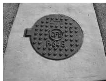
Imagen 22. Registro de la CFE. Foto: Tomada por RMN.
