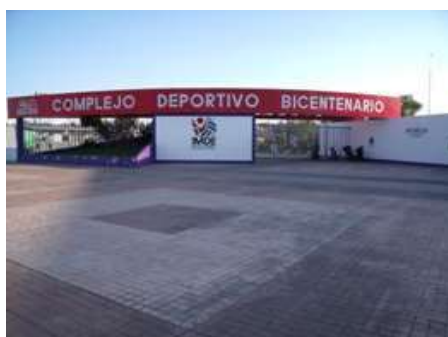
Imagen 26. Acceso principal Complejo Deportivo Bicentenario.
