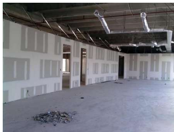
Imagen 6.4. Muros de tablaroca. ( https://fotos.habitissimo.com.mx/foto/fabricacion-de-muro-de-tablaroca_13801 [JUNIO/2018]).
