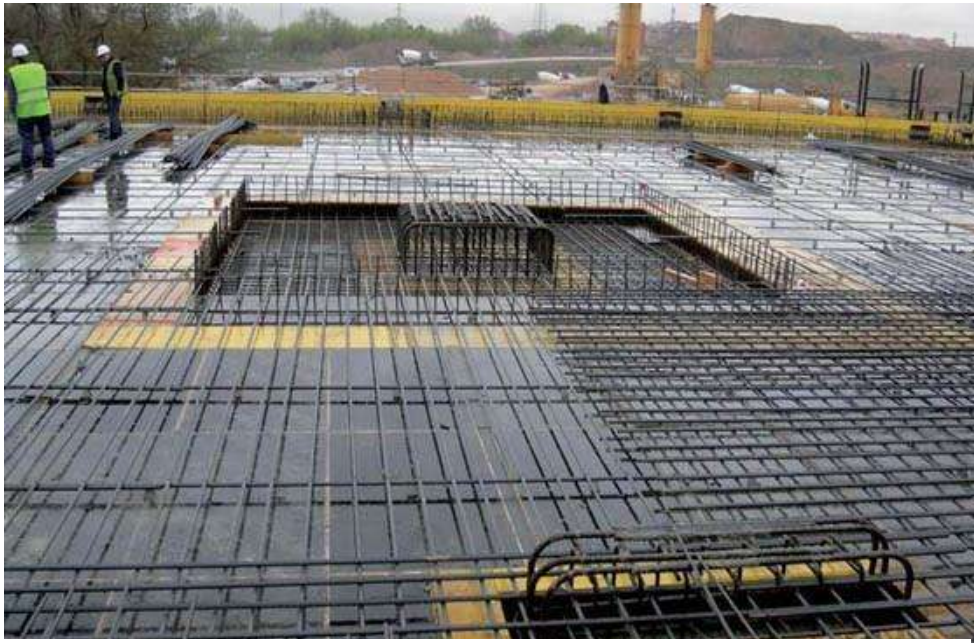
Imagen 6.5. Losa maciza. http://www.arkiplus.com/losa-maciza . [JUNIO/2018]).
