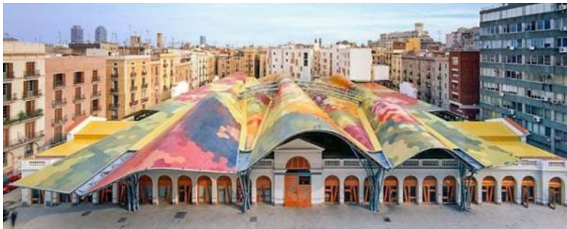
Fig. 37. Imagen de la fachada del mercado Santa Catarina.
