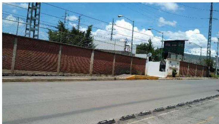
Img. 14 subestación de la C.F.E., foto tomada por; Daniel Ziramba 2018
