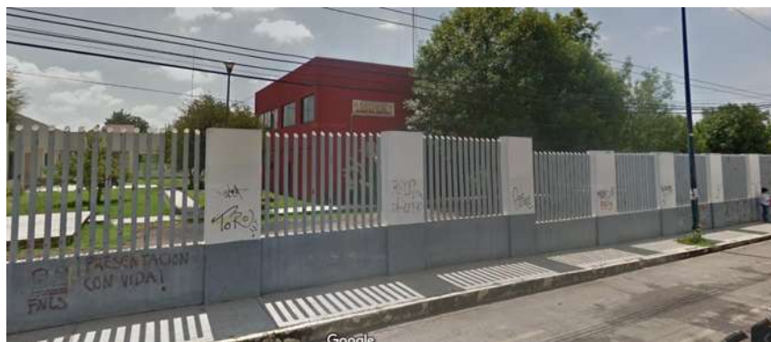
Img. 13 Centro de investigaciones de la Fac. de biología. foto tomada por; Daniel Ziramba 2018
