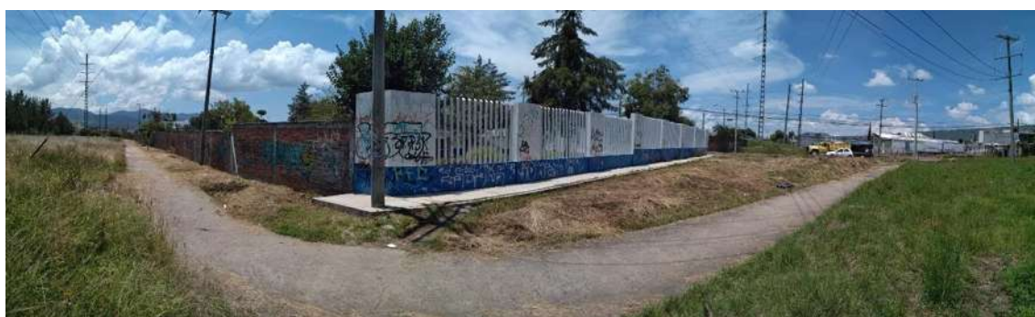
Img. 15 colindancias norte y oeste, foto tomada por: Daniel Ziramba, 2018
