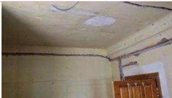
Fig. 6.7: Instalación empotrada
