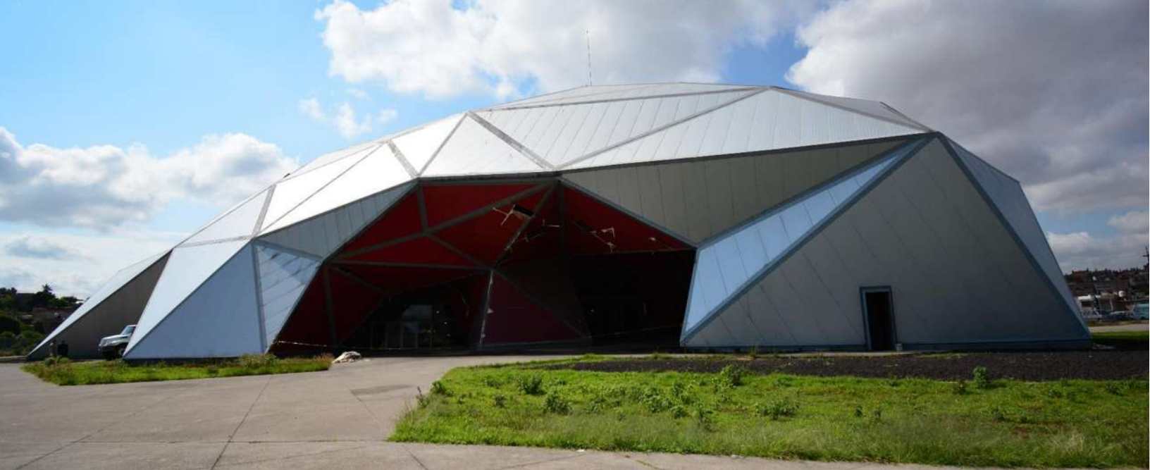
Ilustración 4 Fachada del Auditorio Bicentenario. Fotografía tomada por: Mauricio Carranza Granados. Fecha 07/julio/2018.
