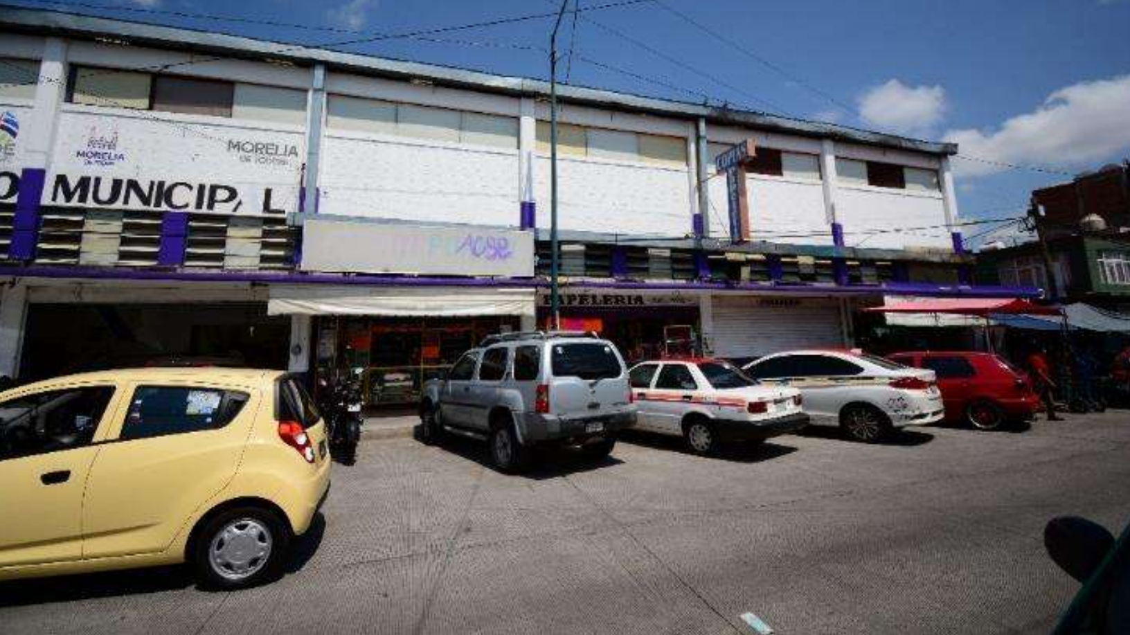
Ilustración 8 Fachada del Auditorio Municipal. Fotografía tomada por Mauricio Carranza Granados. Fecha. Junio 2018.
