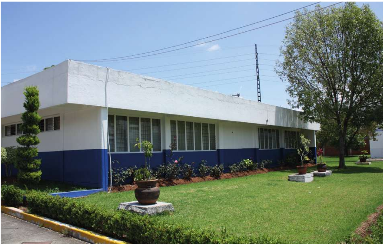
Fotografía 35: Parte oriente de la Clínica (foto tomada por GSM).
