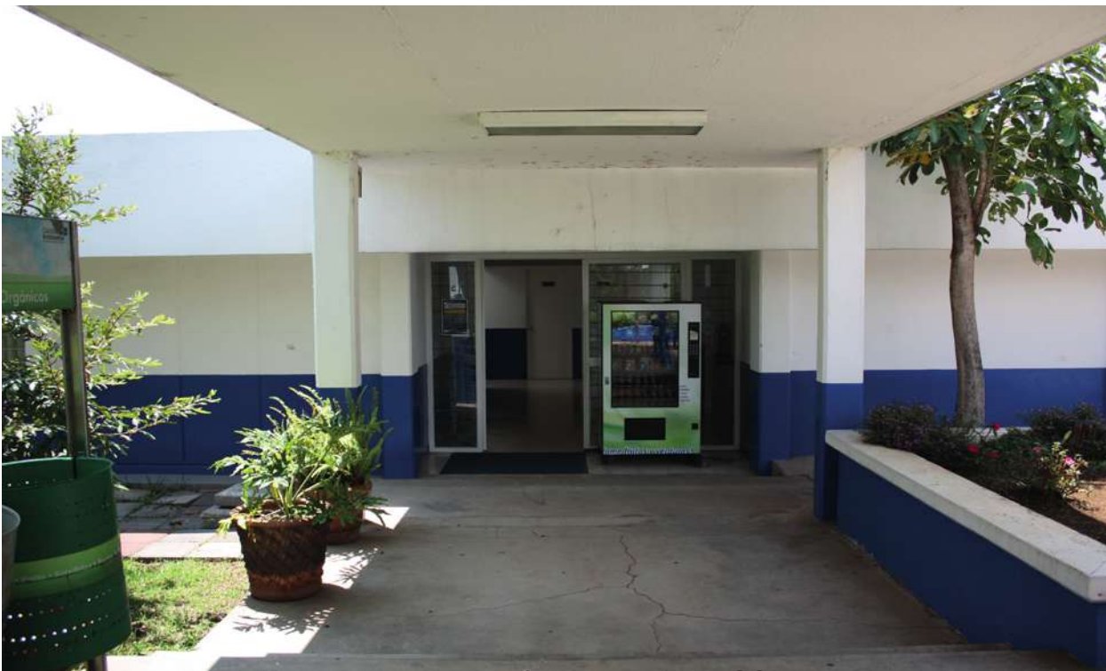
Fotografía 3: Acceso principal a las aulas (foto tomada por GSM9).
