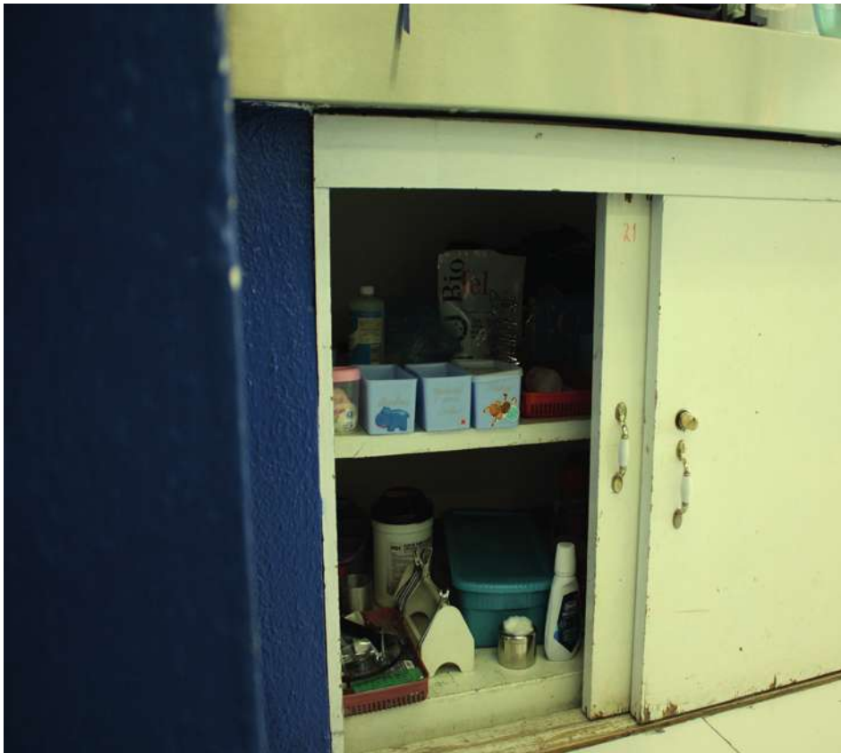
Fotografía 18: Laboratorio de practicas, Edificio de aulas. Fotografía tomada por GSM. Sep. 2015
