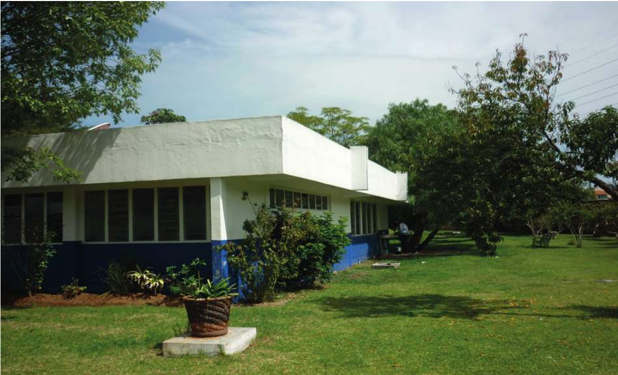
Fotografía 32: Parte sur de las Aulas (foto tomada por GSM).
