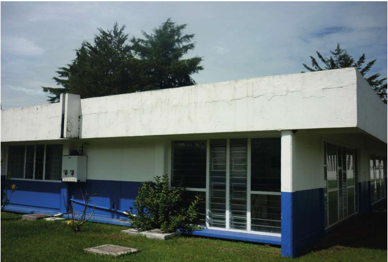
Fotografía 34: Parte sur de la Clínica (foto tomada por GSM).
