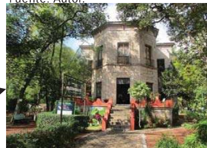
Imagen 88. Fachada Principal del MUHNA (2019). Fuente: Autor.
