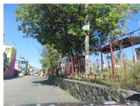
FIGURA 41.-MURO DE MAMPOSTERÍA FUENTE: PROPIA
