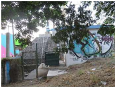
FIGURA 44.-TANQUE DE AGUA FUENTE: PROPIA
