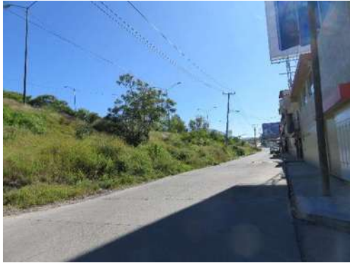
FIGURA 36.-POSTES DE LUZ Y CABLEADO ELÉCTRICO FUENTE: PROPIA
