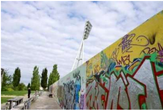
FIGURA. 2.- PARTE DEL MURO CONSERVADA FUENTE: HTTPS://WWW.PUBLICSPACE.ORG/ES/OBRAS/-/PROJECT/W005-MAUERPARC
