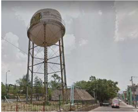
FIGURA 35.- TANQUE ELEVADO DE AGUA POTABLE FUENTE: PROPIA
