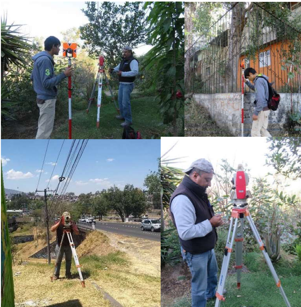
FIGURA. 24.- FOTOGRAFÍAS TOMADAS EN EL SITIO DEL LEVANTAMIENTO TOPOGRÁFICO FUENTE: PROPIA
