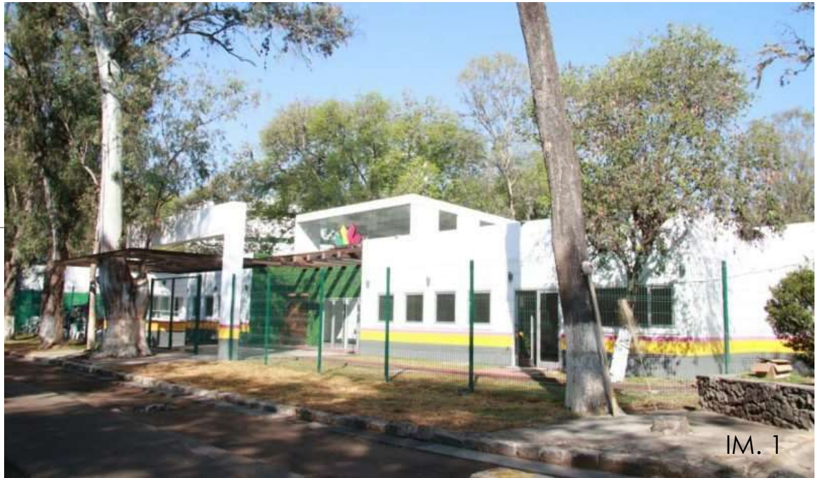
IM. 1 Fachada del Albergue del Hospital Infantil, imagen tomada de http://michoacan.gob.mx/prensa/noticias/inaugura-gobernador-albergue-del-hospital-infantil-de-morelia/
