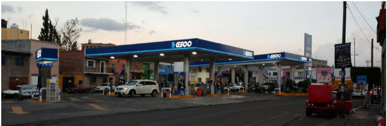
Ilustración 34. Estación de gasolina G500 en calle Plan de Ayala, esquina con Av. Fco. I. Madero, Morelia, Mich. Autor: CSGB, 2018.
