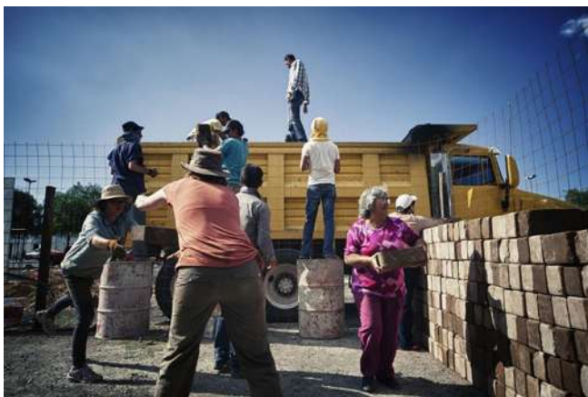
Ilustración 56. Comunidad participando en la construcción del Centro Comunitario La Esperanza, Querétaro. Fuente: Arquitectura Panamericana, 2016.
