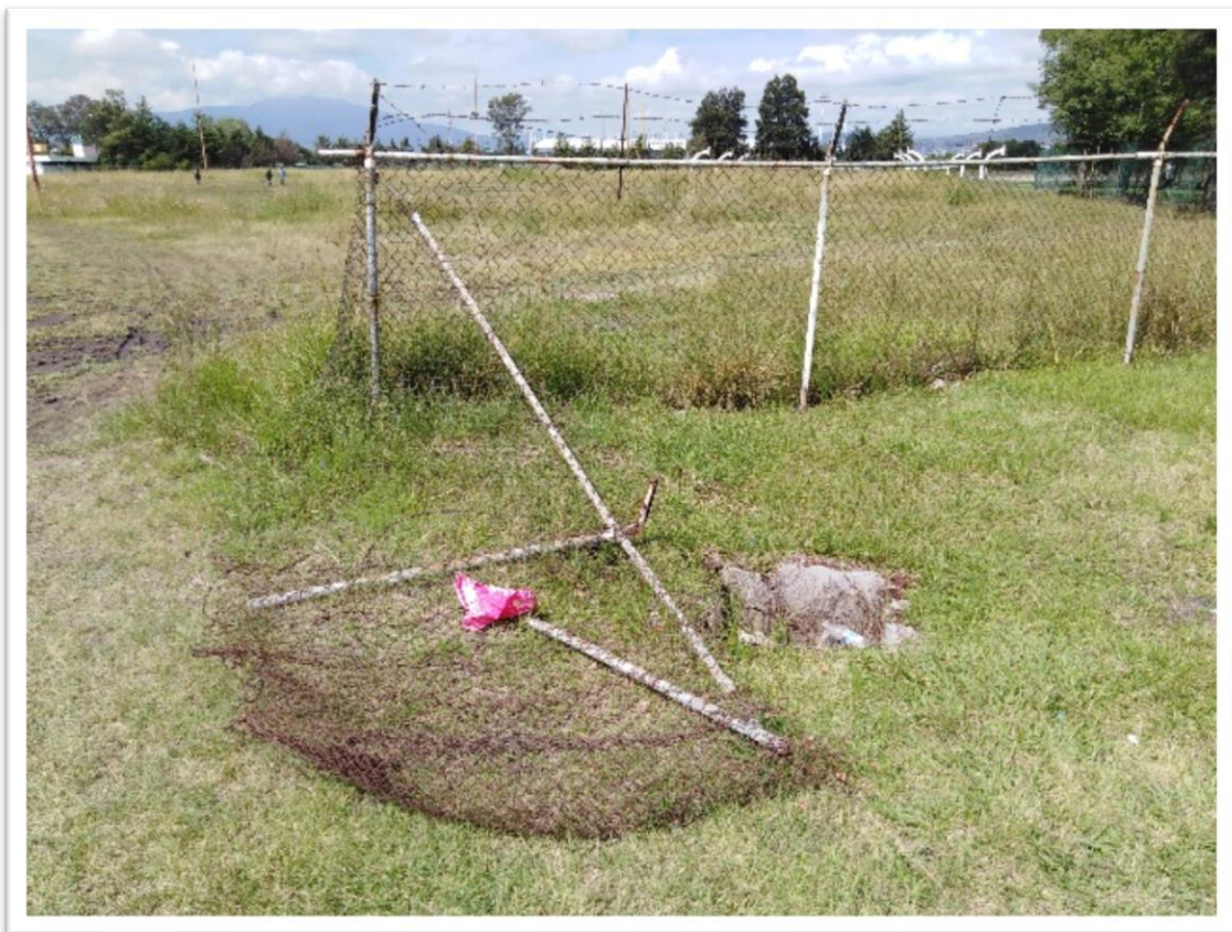
Figura 58. Acceso 4 del Área Deportiva del Campus Universitario, estado actual. Imagen del autor.
