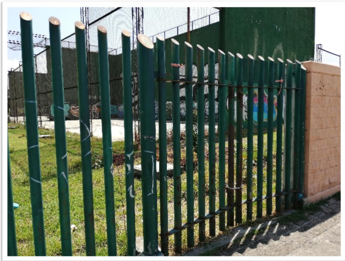
Figura 54. Acceso 3 del Área Deportiva del Campus Universitario, estado actual Imagen del autor
