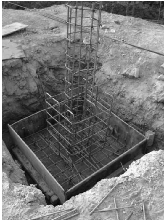
Imagen: 81 Zapata aislada
