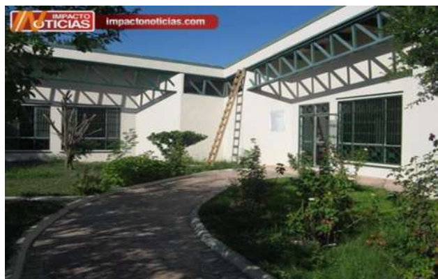
Imagen: 31 Fachada principal
