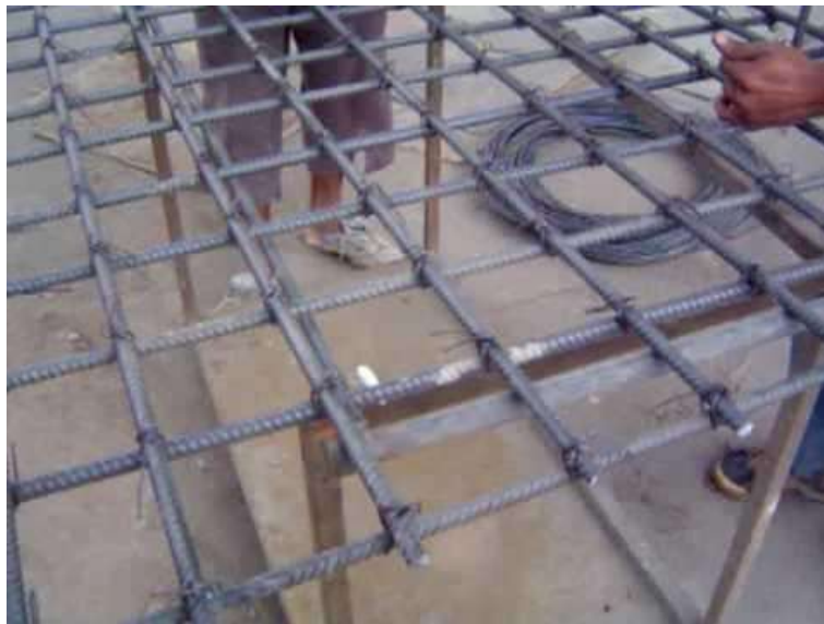
Imagen: 82 Armado de varillas
