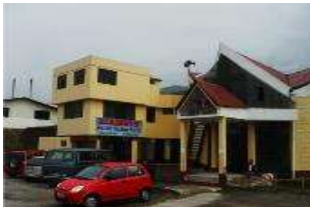
Imagen: 11 Fachada principal
