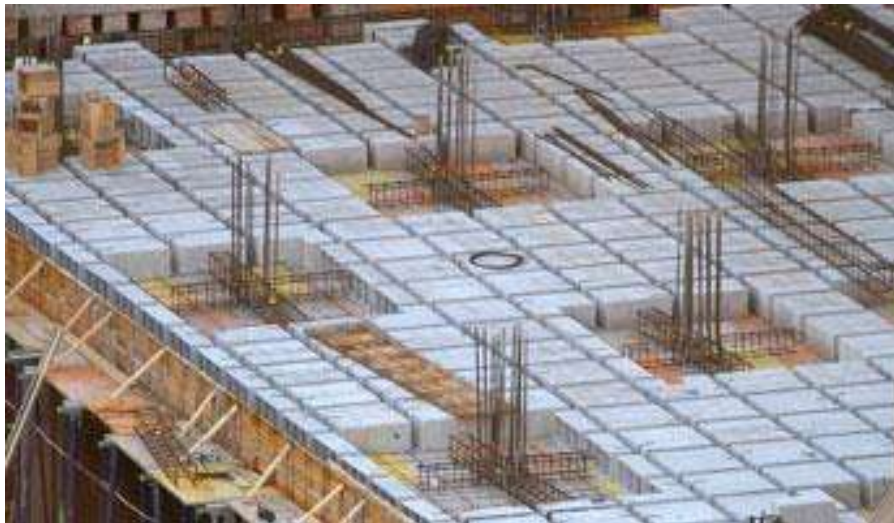
Imagen:86 Armado en losas
