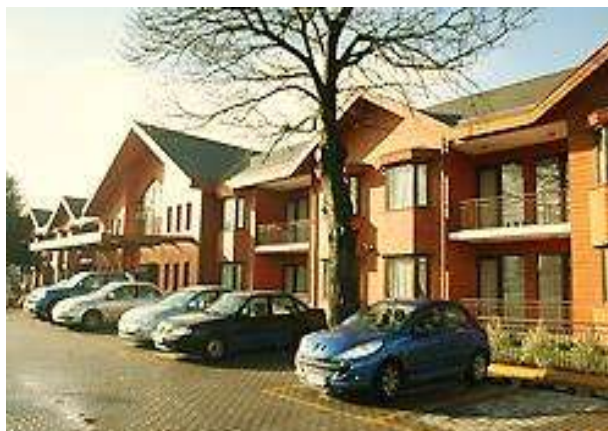
Imagen: 1 Fachada principal
