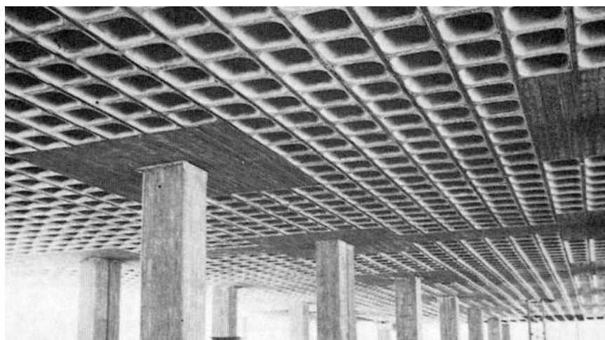
Imagen: 80 Losa reticular
