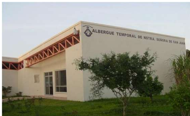
Imagen: 12 Fachada Lateral
