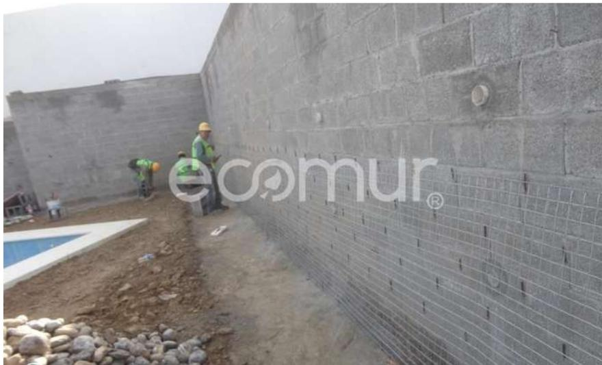
**Fig. 35.** Habilitado de acero para la construcción de muros de gavión.
