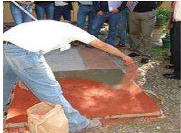
**Fig. 46.** Aplicación del color al concreto. Fuente:
