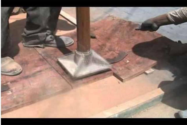
**Fig. 47.** Aplicación de los moldes con el pisón. Fuente:
