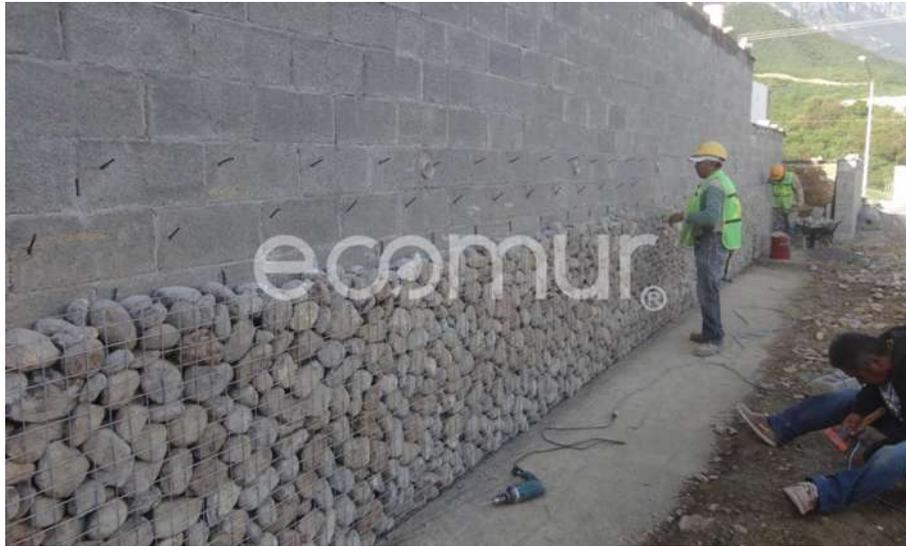
**Fig. 36.** Llenado de muro con piedras.
