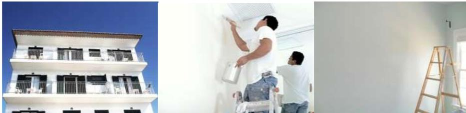
**Fig. 44.** Aplicación de la pintura aislante de calor.
