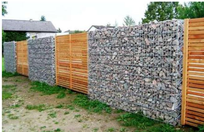
**Fig. 40.** Uso de gavión en muros perimetrales. Fuente: <http://www.ecomur.mx/gavion>
