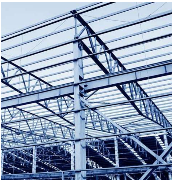
Ilustración 54: Estructura metálica de nave industrial Fuente: (MABASA, 2015)
