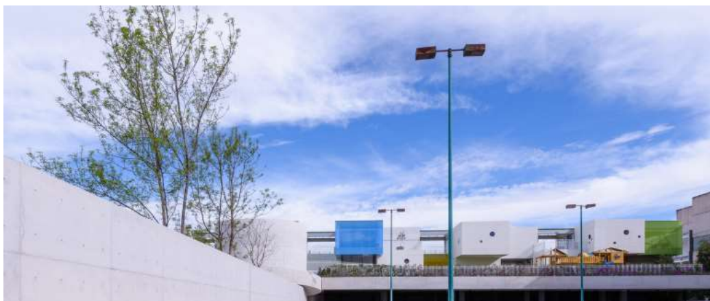
Imagen 28 Fachada del preescolar Monte Sinaí
