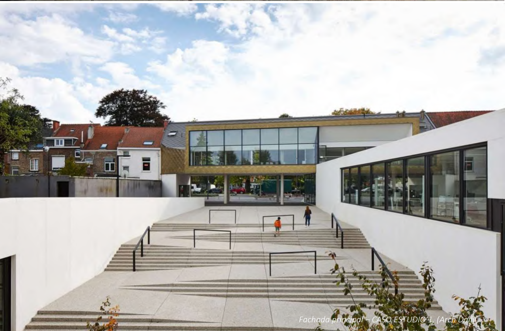
Vista desde la calle – CASO ESTUDIO 1, (Arch Daily)
