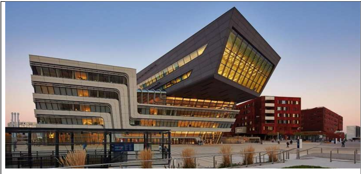
Fig. No. 1. Fachada principal. Fuente: http://obrasweb.mx/arquitectura/2015/05/15/5-universidades-que-inspiran [septiembre25,2018]
