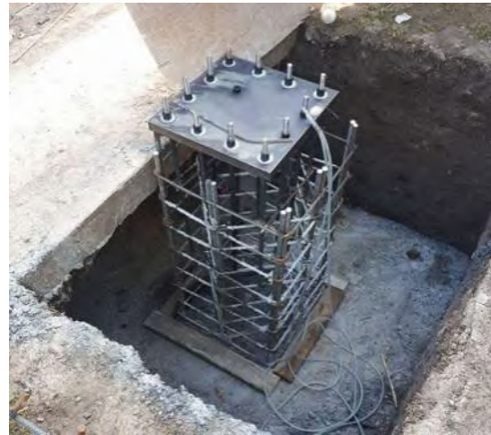
Fig. 72: Zapata aislada.
