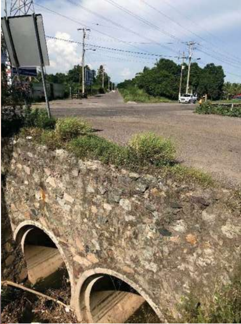
IMG. 109 drenaje, Luis Magaña, 18/Sep/2018
