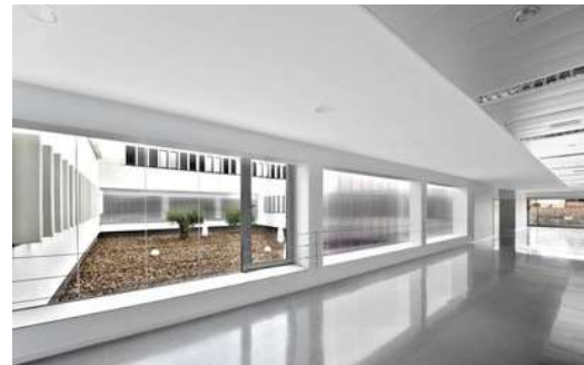
Ilustración 6 Para este edificio se ha utilizado un tipo de ventana que evita la monotonía de la ventana apaisada y mejora sus condiciones bioclimáticas. Los montantes de hormigón prefabricados enmarcan ventanas transparentes alternando con paneles de vidrio traslúcido que ocultan pilares y tabiques.
