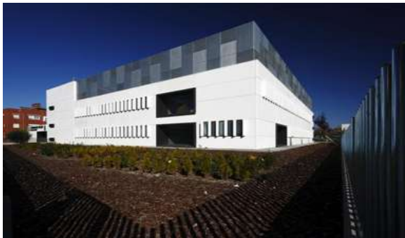
Ilustración 5 El elemento central del centro de salud es un gran patio rectangular, alrededor del cual se agrupan todas las funciones. El gran patio central permite la controlar las condiciones térmicas exteriores así como la iluminación natural de los espacios interiores.
