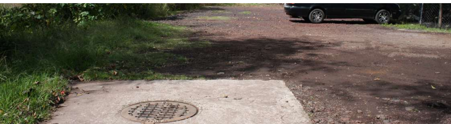
Imagen 33- tapa de drenaje de la red de alcantarillado D.K.H.Q
