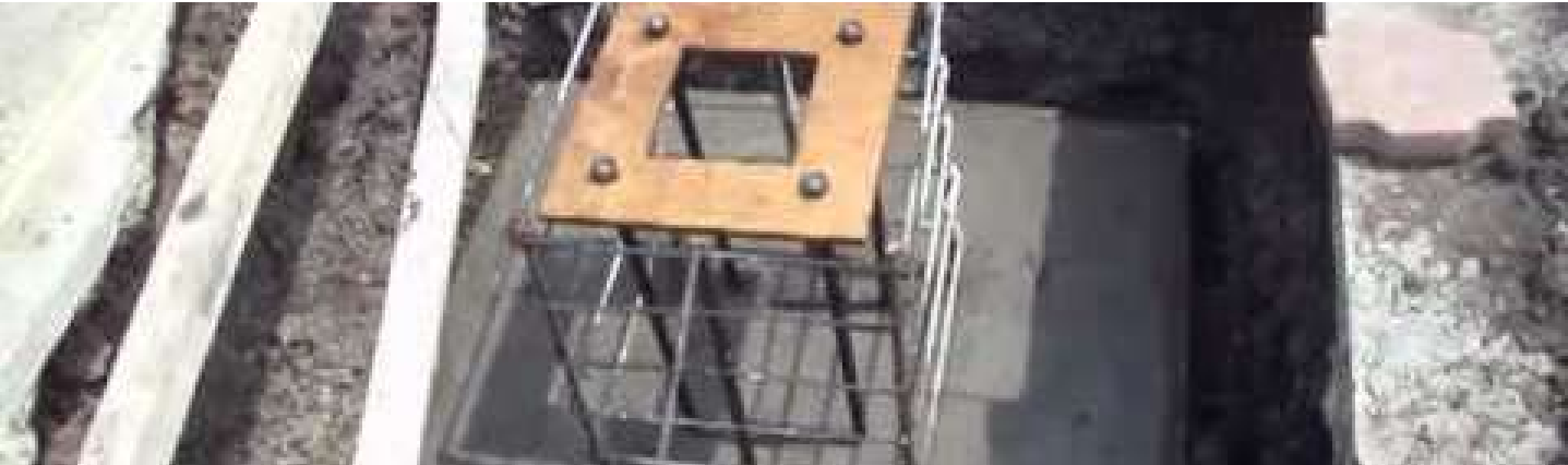
Imagen 74.- Zapata Aislada < https://www.construmatica.com/construpedia/Zapatas_Aisladas > [06/02/19]
