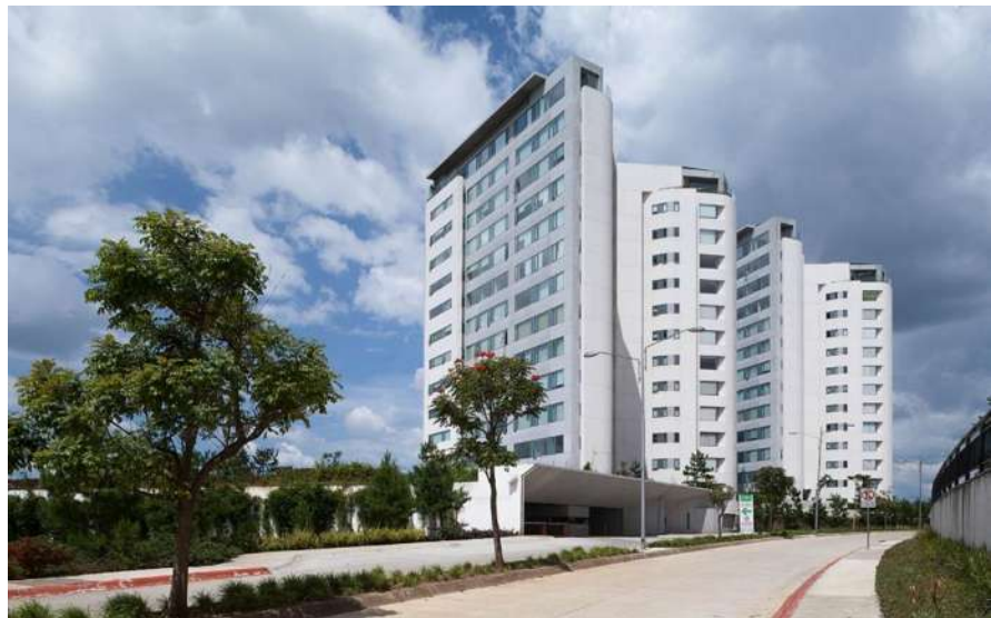
Imagen 45. Mostrando fachada de conjunto proyecto Altozano Morelia.
