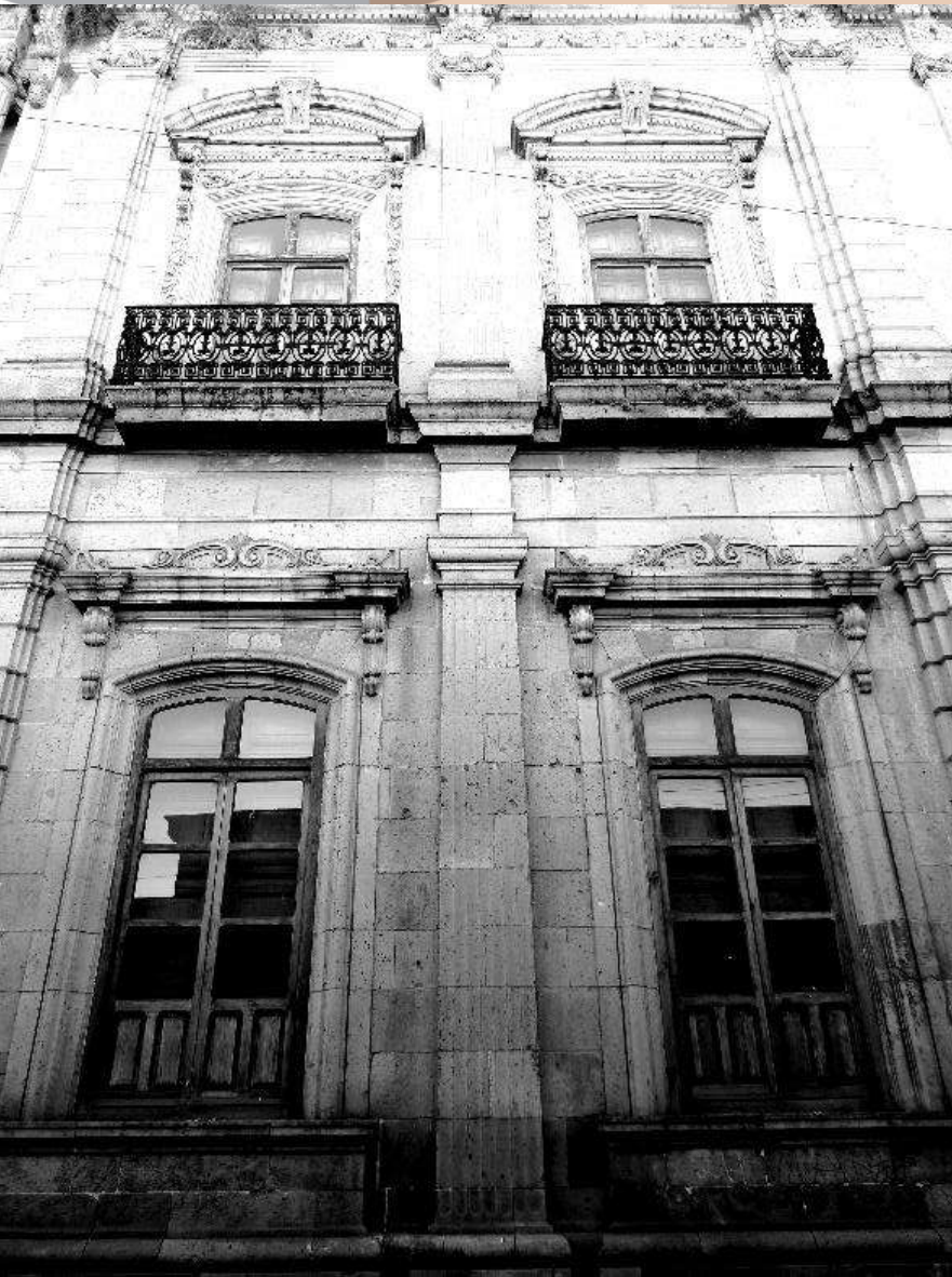
Figura 1: Arquitectura colonial en el Centro Histórico de la ciudad. Fuente: Archivo personal.
