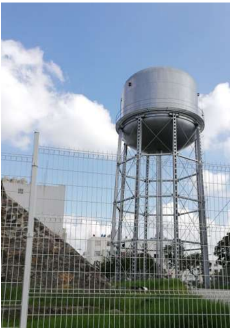
Fotografía 21. Tanque elevado. Fotografía tomada por el autor.
