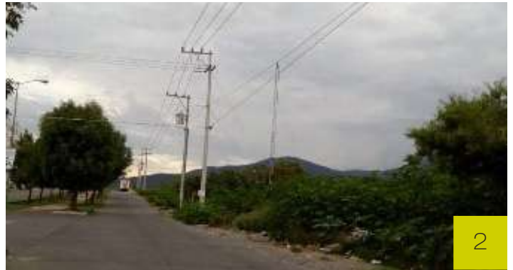
Fotografía 36. Red eléctrica. Fotografía tomada por el autor.
