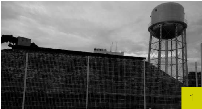
Fotografía 35. Aljibe y tanque elevado. Fotografía tomada por el autor.
