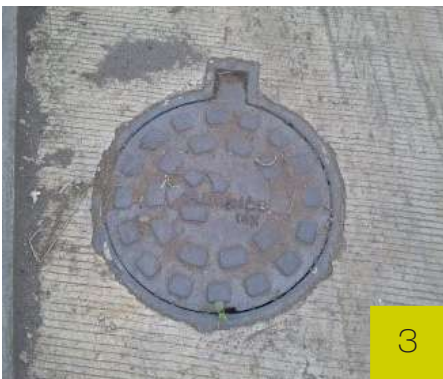
Fotografía 37. Alcantarilla de drenaje ecológico. Fotografía tomada por el autor.
