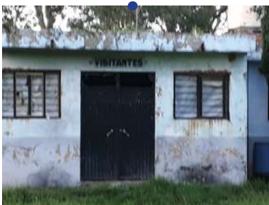
4 Vista de la fachada de los vestidores.
