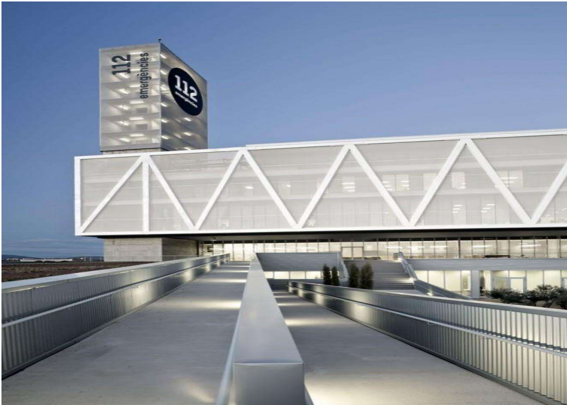
Fig.19 Adria Goula Edificio 112, https://www.archdaily.mx/mx/02-125303/edificio-112-acxt-arquitectos/512c70a5b3fc4b11a700db2d-edificio-112-acxt-arquitectos-foto (Agosto, 2019)
