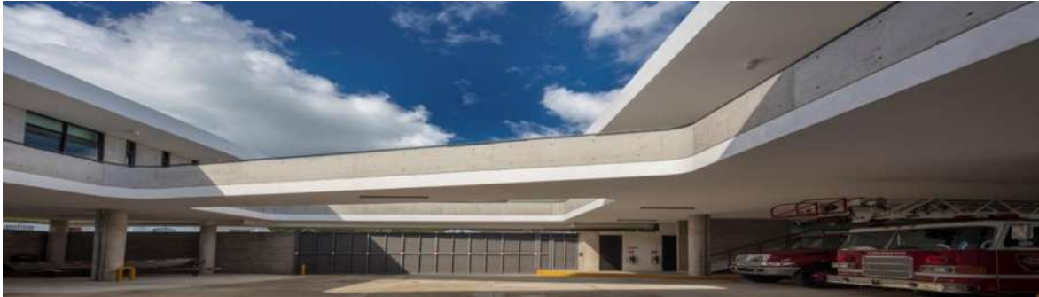
Fig. 24, estación de bomberos boca / taller diez 05, https://www.archdaily.mx/mx/885257/estacion-de-bomberos-boca-taller-diez-05/5a2ee12fb22e388411000030-estacion-de-bomberos-boca-taller-diez-05-foto-septiembre,2018 ]
