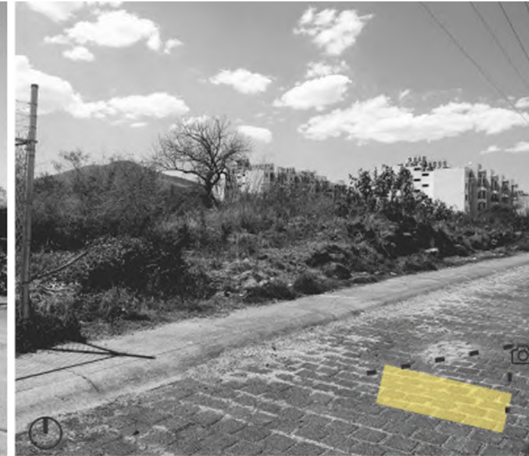
Figura # . Estado de conservacion del predio actual.
