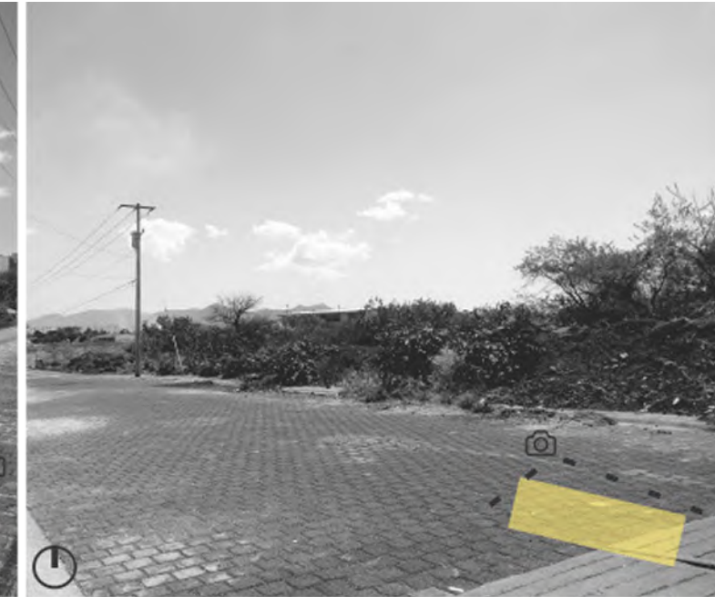
Figura # . Estado de conservacion del predio actual.
