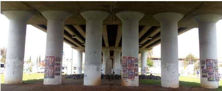
54 Estado actual de la imagen de las columnas. P. Arq. FVGG. Julio 2019
