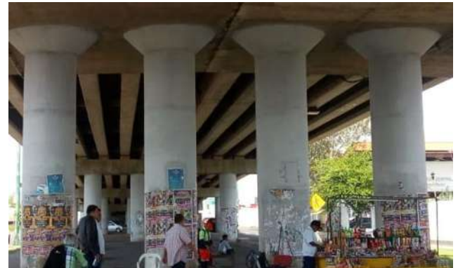
55 Estado actual de la imagen de las columnas. P. Arq. FVGG. Julio 2019.
