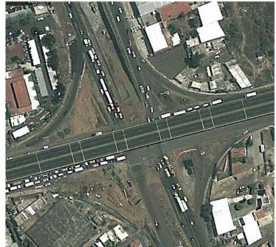
6 Distribuidor vial salida Quiroga. Imagen satelital de google earth. Fecha de imagen mayo 2011.
