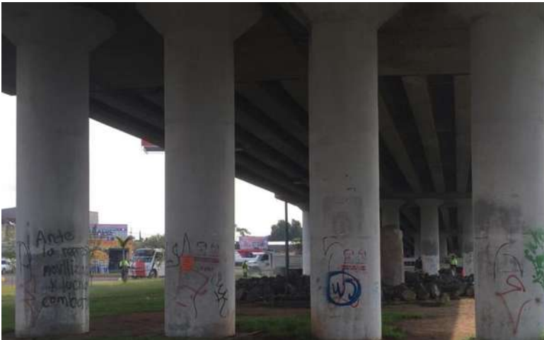
56 Estado actual de la imagen de las columnas. P. Arq. FVGG. Julio 2019.
