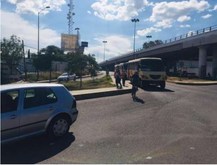
38 Cruce peatonal actual Suroeste . P. Arq. FVGG. Agosto 2019
