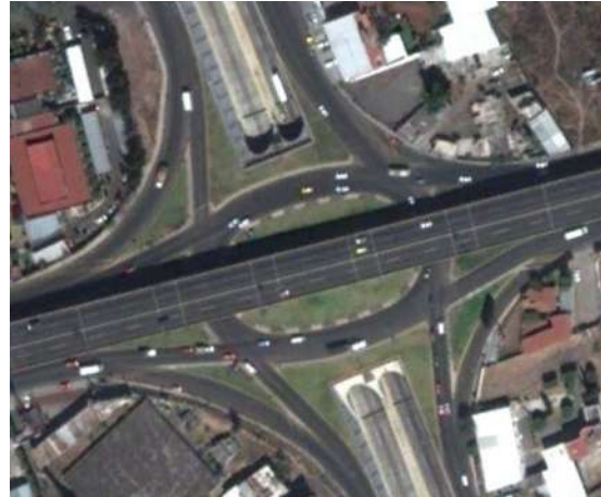
8 Distribuidor vial salida Quiroga. Imagen satelital de google earth. Fecha de imagen febrero 2013.
