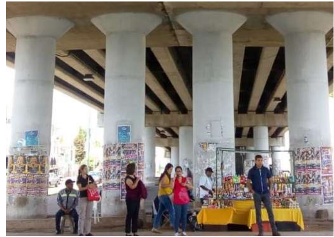
57 Estado actual de la imagen de las columnas. P. Arq. FVGG. Julio 2019.
