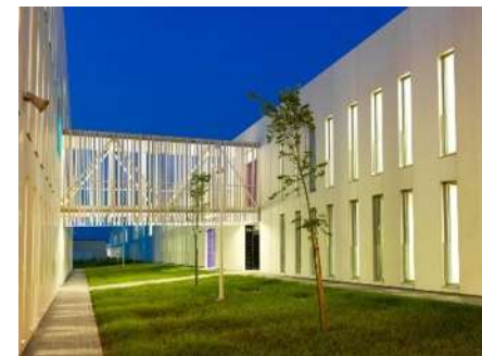
Imagen 17 Exterior del edificio, fuente: Archidaly.
