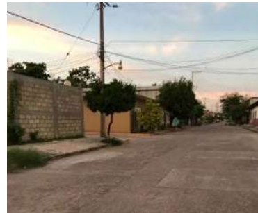
Imagen 38 Red de energía eléctrica, fotografía propia.
