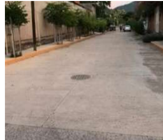
Imagen 37 Red de drenaje, fotografía propia.
