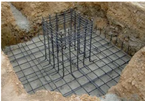
Imagen 4.21 Zapata aislada de concreto armado, Fuente: http://dearkitectura.blogspot.com/2012/04/la-cimentacion-tipos-de-cimientos.html , [25/08/2019]
