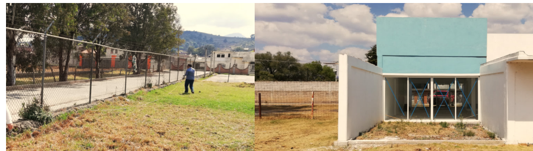
Figuras 44, 45, 46 y 47. Fotografías del estado actual del exterior. Elaboración propia.
