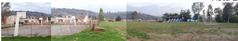
Figura 31. Larguillo, vista Sur del predio. Autor: LCA.
