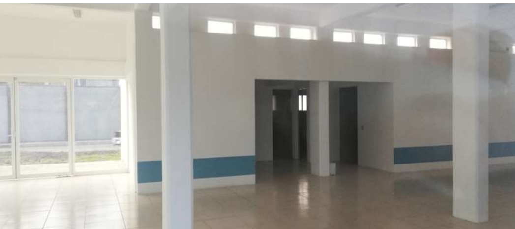
Figura 48, 49 y 50. Fotografías del estado actual del interior. Elaboración propia.
