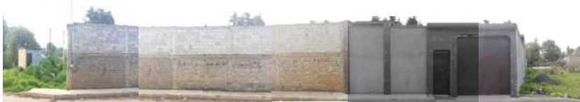
Figura 28. Larguillo, vista Norte del predio. Autor: LCA.
