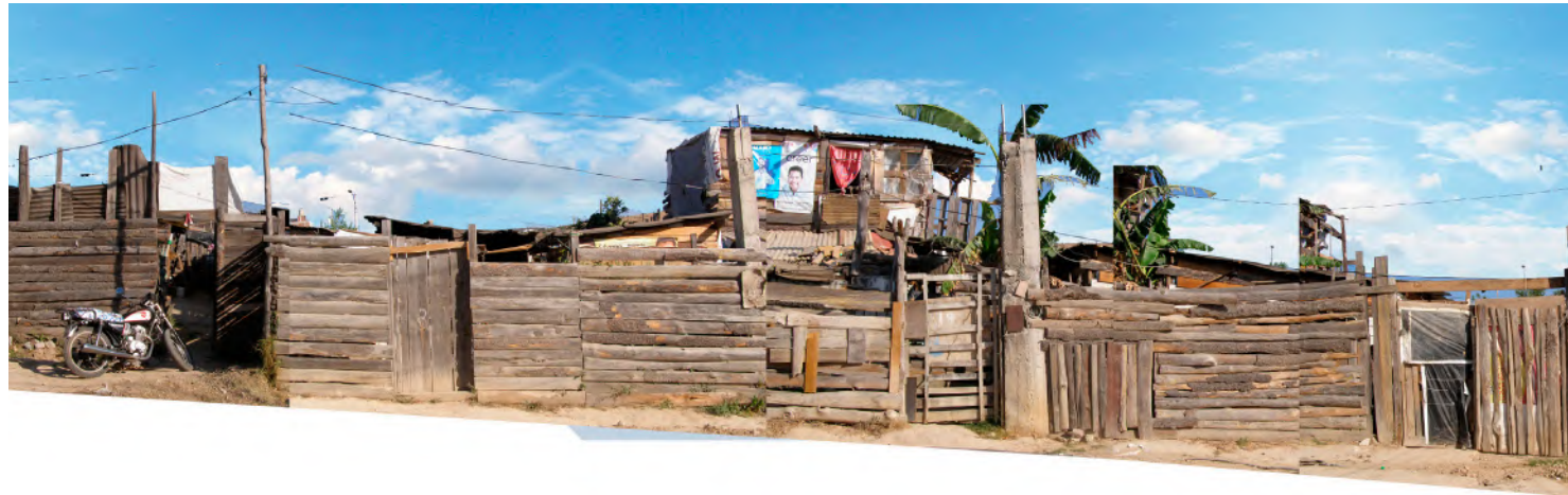
IMG 76. Ampliación larguillo (V-06) Vista: V-14.
