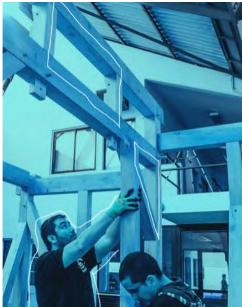
IMG 101. Construcción vivienda progresiva de madera
