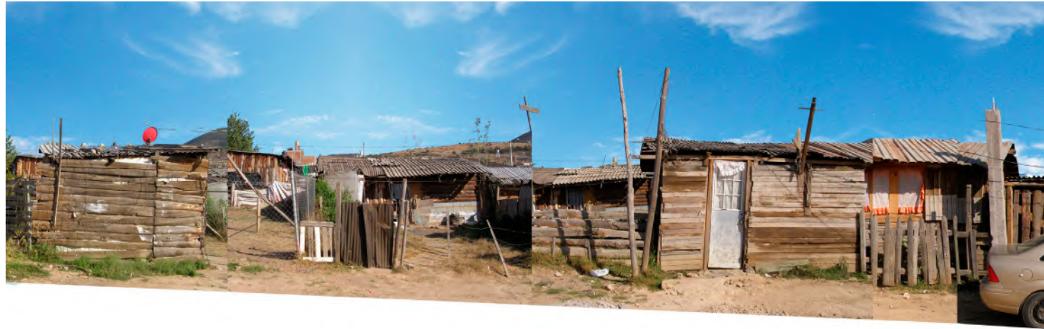
IMG 75. Ampliación larguillo (V-06) Vista: V-13.
