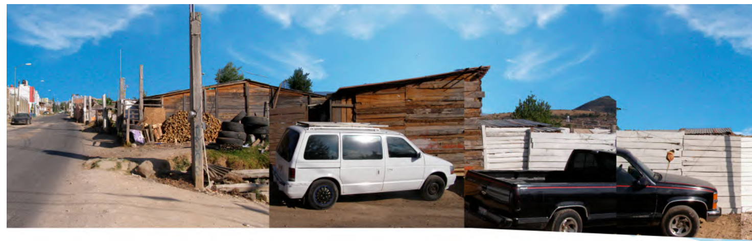
IMG 74. Ampliación larguillo (V-06) Vista: V-12.
