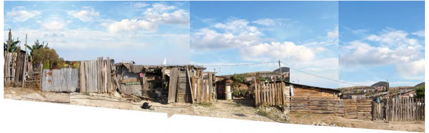
IMG 77. Ampliación larguillo (V-06) Vista: V-15.
