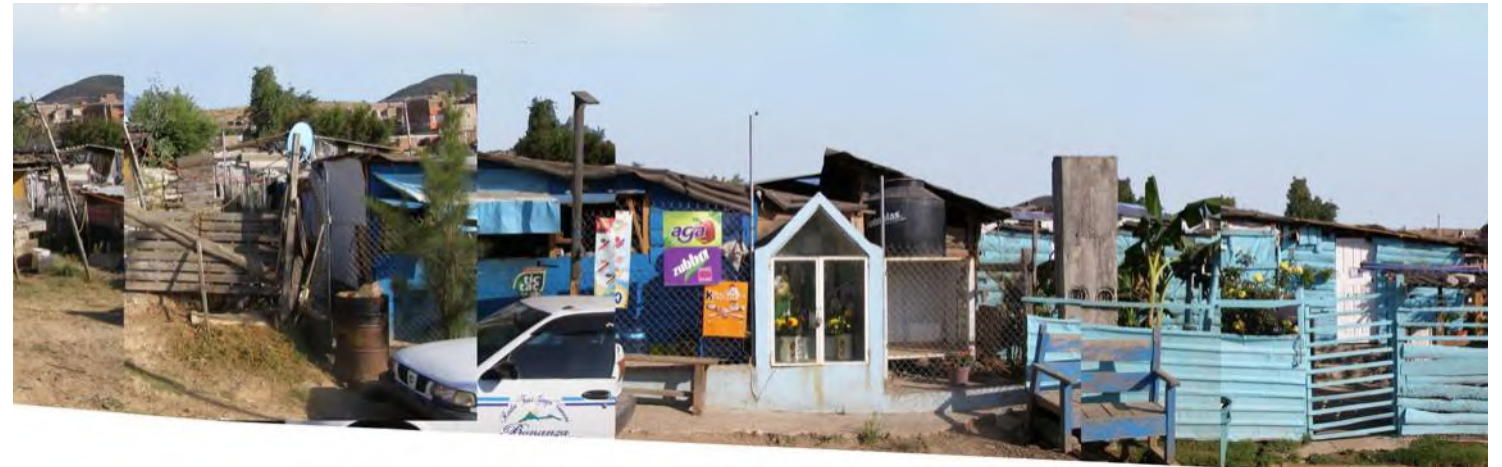
IMG 78. Ampliación larguillo (V-06) Vista: V-16.
