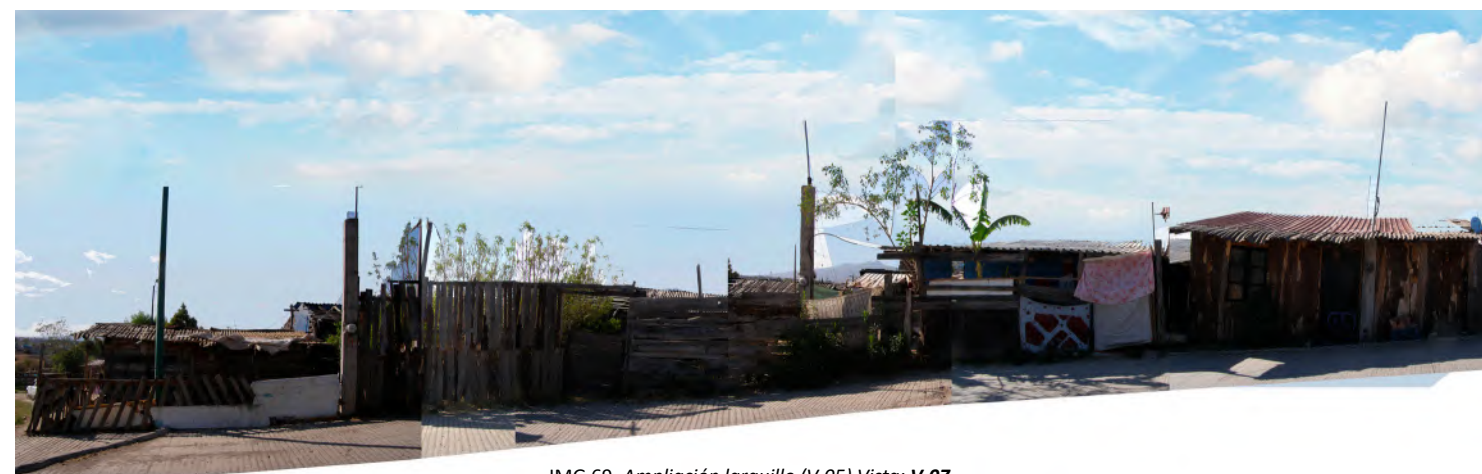
IMG 69. Ampliación larguillo (V-05) Vista: V-07 .
