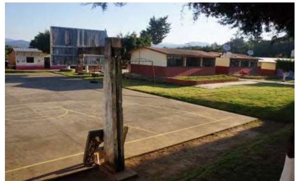
Imágen 5.- Estado Actual Primaria. Vista de los salones y cancha de basquetball. Autor: José Armando Silverio Vargas. 20-AGOSTO-2019
