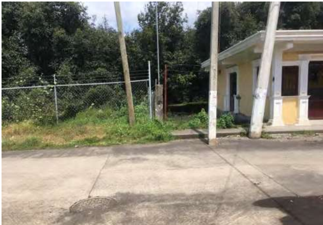
Imagen 68.-Ubicación de infraestructura en el sitio. Autor Jose Armando Silverio Vargas 04-NOVIEMBRE-2019
