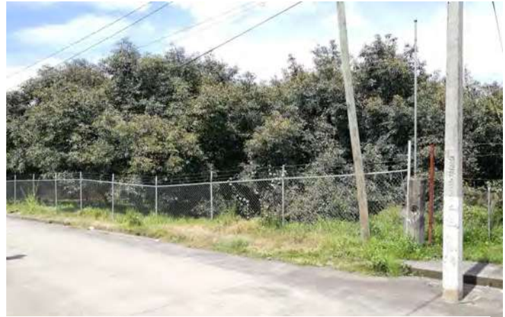
Imagen 67.- Ubicación de infraestructura en el sitio. Autor Jose Armando Silverio Vargas. 04-NOVIEMBRE-2019
