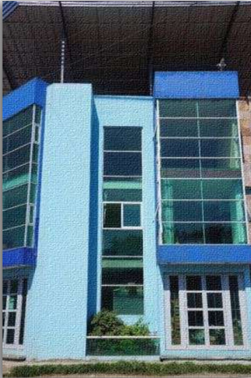
Ilustración 3 Edificación de uso mixto de tres niveles ubicada en la calle de acceso al pueblo, que rompe con la arquitectura tradicional del pueblo, Fuente: Erick Daniel Melgoza Alejandre, Miguel Ángel Aparicio Santiago, Fecha: Agosto/2018
