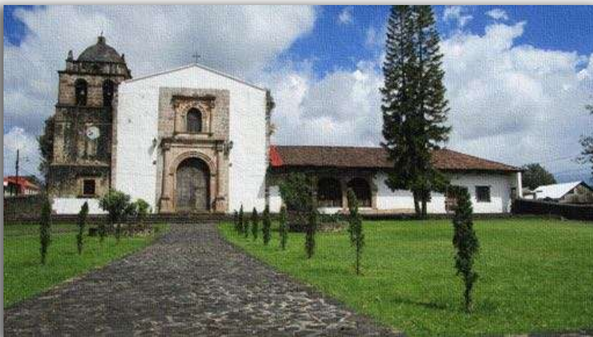
Ilustración 15 Fachada principal del convento de Zacán, Michoacán. Ostenta elementos de filiación manierista; su paramento contrasta con el volumen que alcanza la torre. Zacán fue evangelizado por los frailes franciscanos, pero después fue cedido a los agustinos, Fuente:
