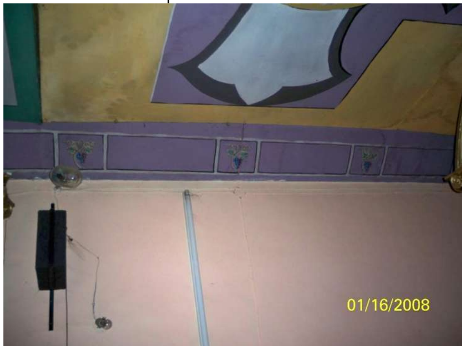
Deterioro: Humedad en plafón.
