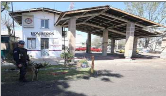
(img.1) Estado actual de la estación de bomberos número 2, en ciudad industrial. Morelia. Fotografía por, Gabriel Villegas.
