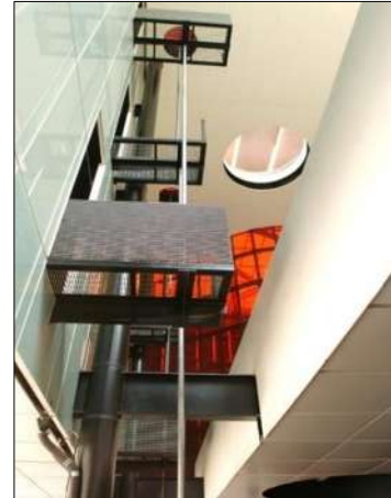
(img.14) Circulaciones verticales estación de bomberos "ave fénix", https://www.google.com/search?q=estacion+de+bomberos+ave+fénix+&tbm=isch&ved=2ahUKEwikzNy_u5nrAhVN_awKHZV6DZQ2-y_u5nrAhVN_awKHZV6DZQ2-
