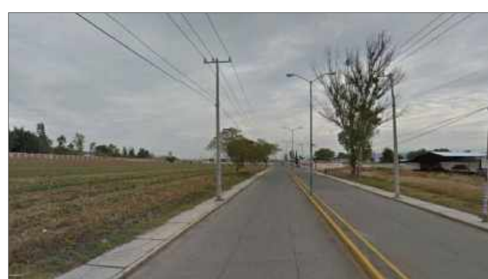
Toma fotografica de poste de luz/teléfono 1
