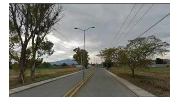
Toma fotografica de luminarias 1 y 2
