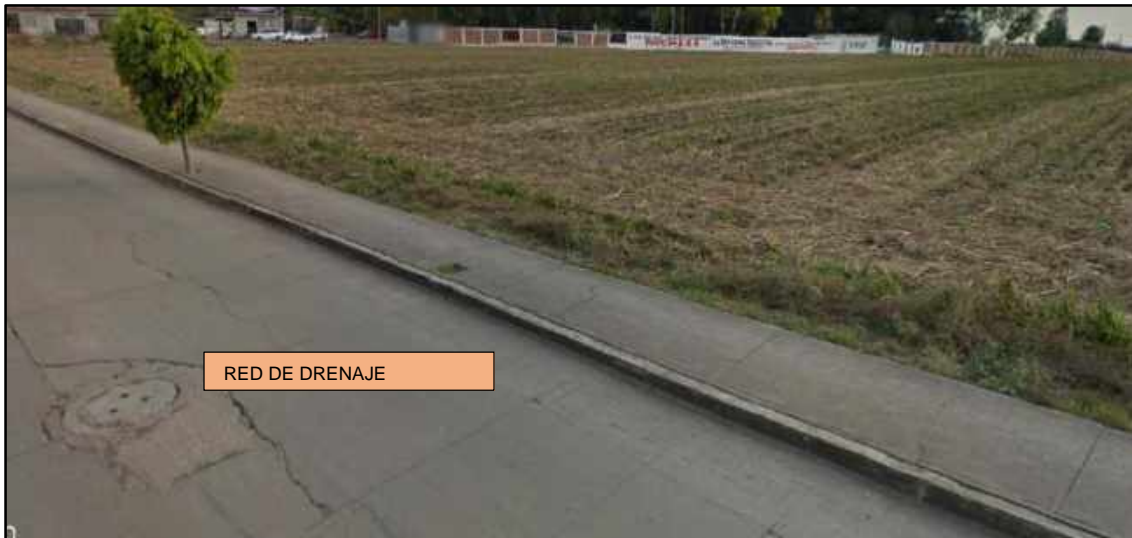
Imagen. 34 Ubicación de tubería de drenaje en el predio.
