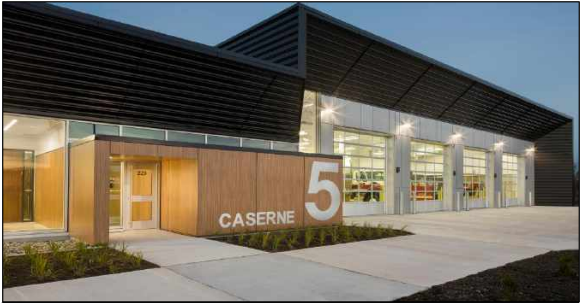
Imagen. 11 Estación de Bomberos #5.
