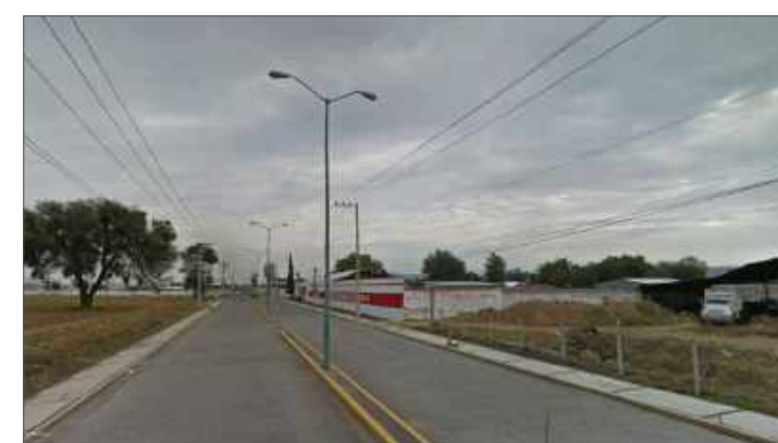
Toma fotografica de luminarias 3 y 4
