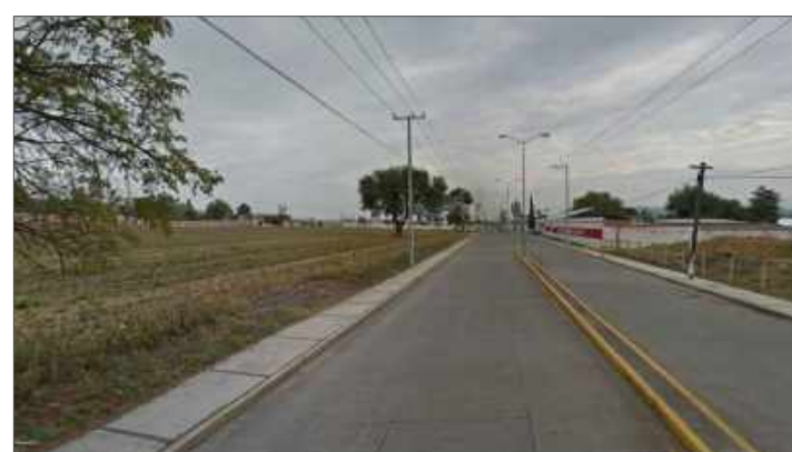
Toma fotografica de poste de luz/teléfono 3
