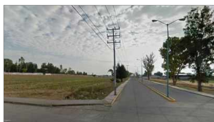
Toma fotografica de poste de luz/teléfono 2
