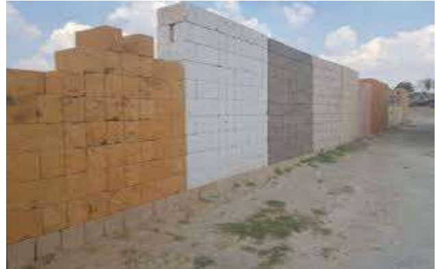
Imagen 84. Muro de muestra se sillar de diferentes colores. Recuperado de: https://bit.ly/3iJ5KL9
