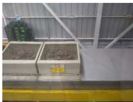
Imagen 10. Se observa la oarte de la maquina cepilladora cubierta. Fotografía tomada por R.M.G.
