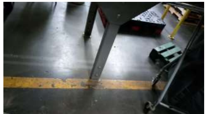
Imagen 53. Anclaje de las máquinas al piso de la nave empaquetadora. Fotografía tomada por R.M.C.
