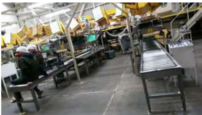
Imagen 57. Banda compuesta de tubos para transportar as cajas llenas. Fotografía tomada por R.M.C.
