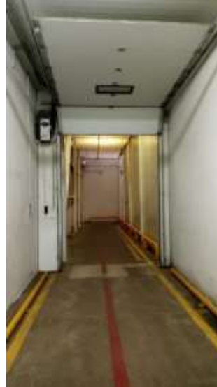
Imagen 66. Pasillo con una de las puertas dobles. Fotografía tomada por R.M.C.
